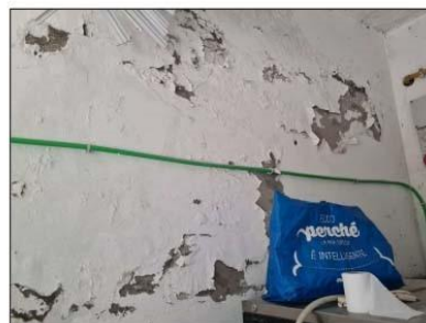
FOTO 105 - UMIDITA' E INFILTRAZIONI
