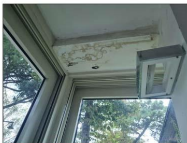
FOTO 98 - INFILTRAZIONE CONTROS.
