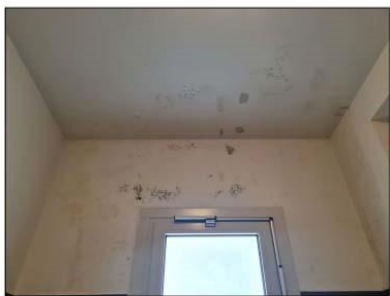
FOTO 100 - INFILTRAZIONI E MUFFE
