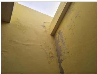
FOTO 101 - INFILTRAZIONE COPERT.
