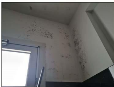
FOTO 102 - INFILTRAZIONI E MUFFE
