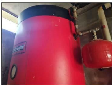
FOTO 53 - ACCUMULO ACQUA CALDA
