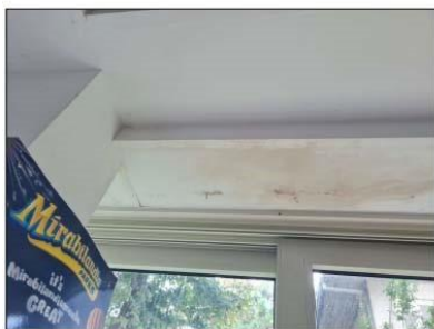
FOTO 97 - INFILTRAZIONE CONTROS.
